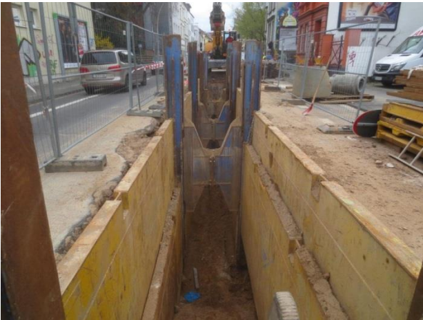
Römerstraße in der Bauphase
