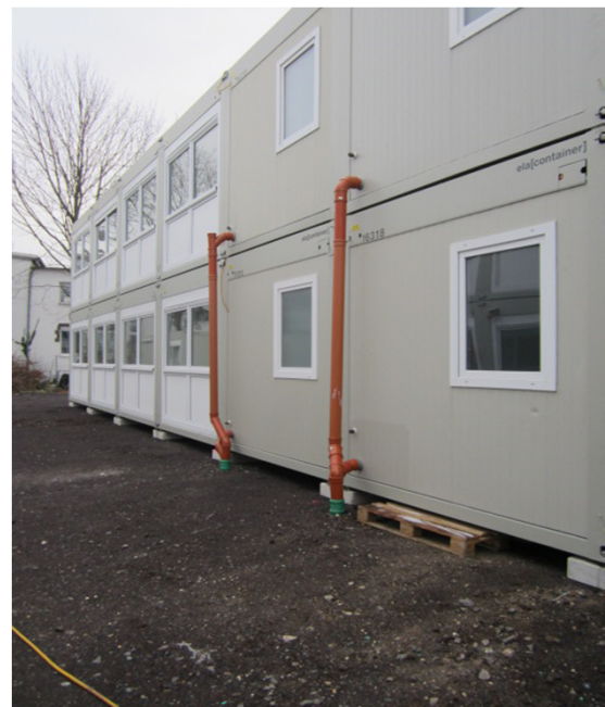
Container, zwei-stöckig, von hinten (Wohn- und Sanitär-Container)
