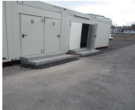
Container, ein-stöckig, von vorne (Sanitär-C.)
