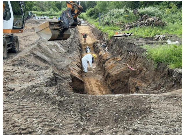
Kanalbau Hauptkanal da 355 PEHD
