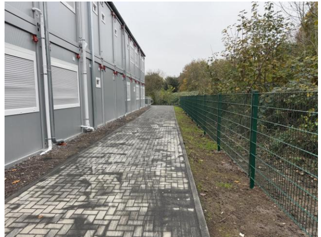
Container, zweigeschossig, Gehweg Fertigstellung
