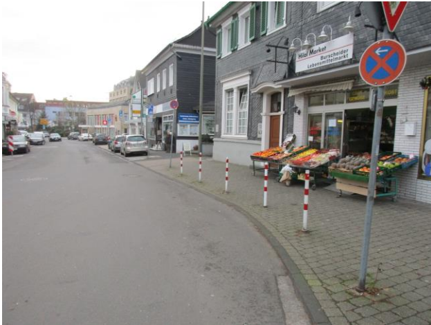
Straße vor Umbau
