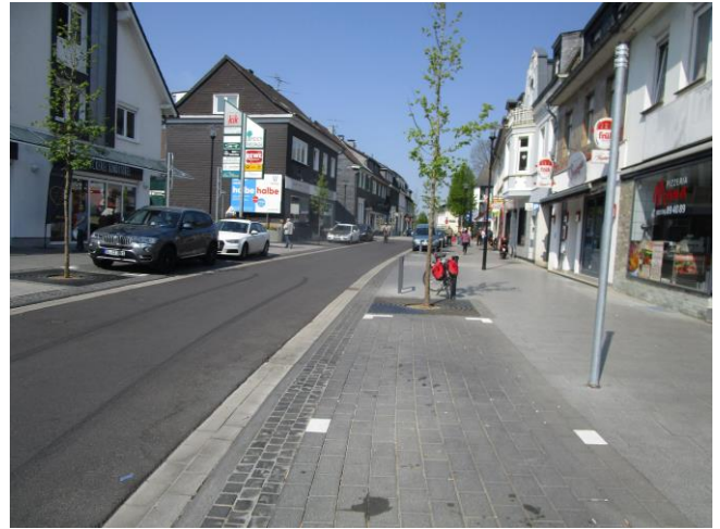
fertige neue Straße
